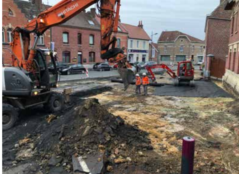
La première étape a consisté à décaper la couche superficielle et à reconstituer un fond de bonne qualité.
