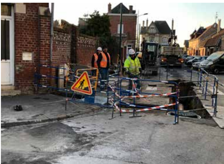
La CAD profite des travaux pour revoir des canalisations vieillissantes depuis la rue du château.
